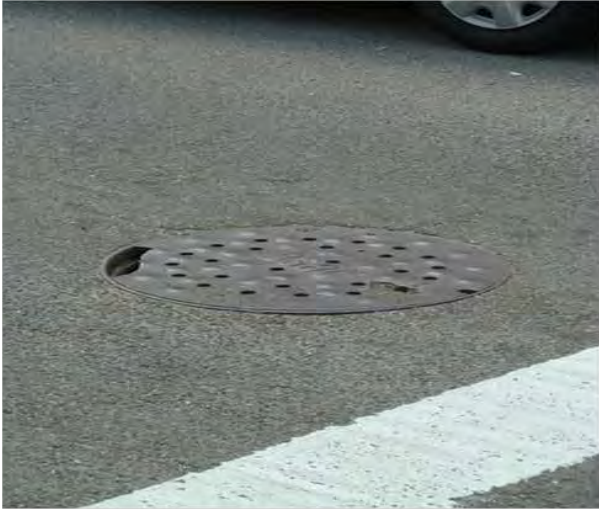
Broken Manhole
